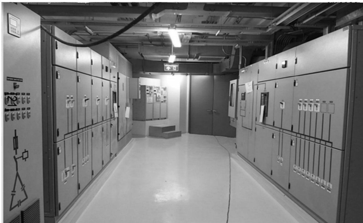
รูปที่ 8.3 ตัวอย่างห้องที่ติดตั้งแผงสวิตช์และพื้นที่ว่างเพื่อปฏิบัติงานที่ดี
